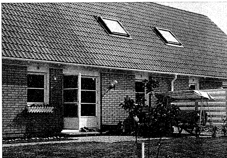
Ett av parhusen inom kv Domaren, Helsingborg.
